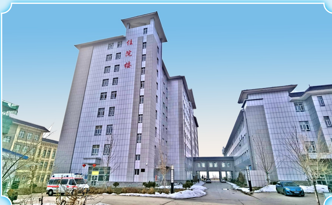
2022年1月13日,霍尔果斯市人民医院及附属配套设施建设项目(住院楼)一标段项目获新疆建筑工程天山奖。图为获奖配套设施
