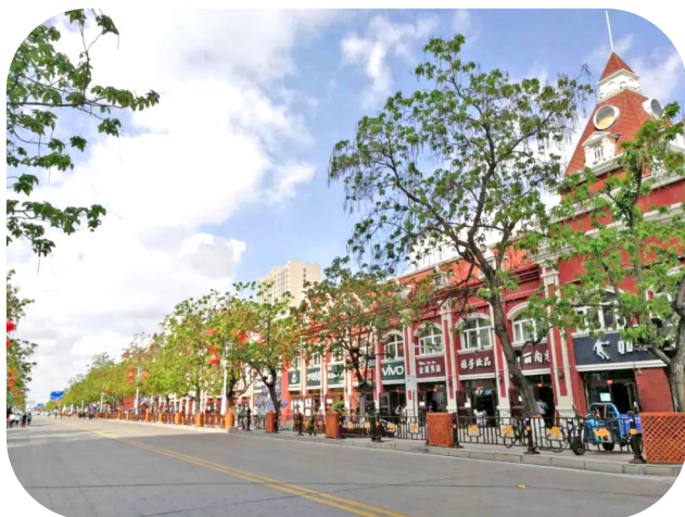
2019年6月,霍尔果斯市开展城市面貌提升改造工程,改造后的街道面貌一新
